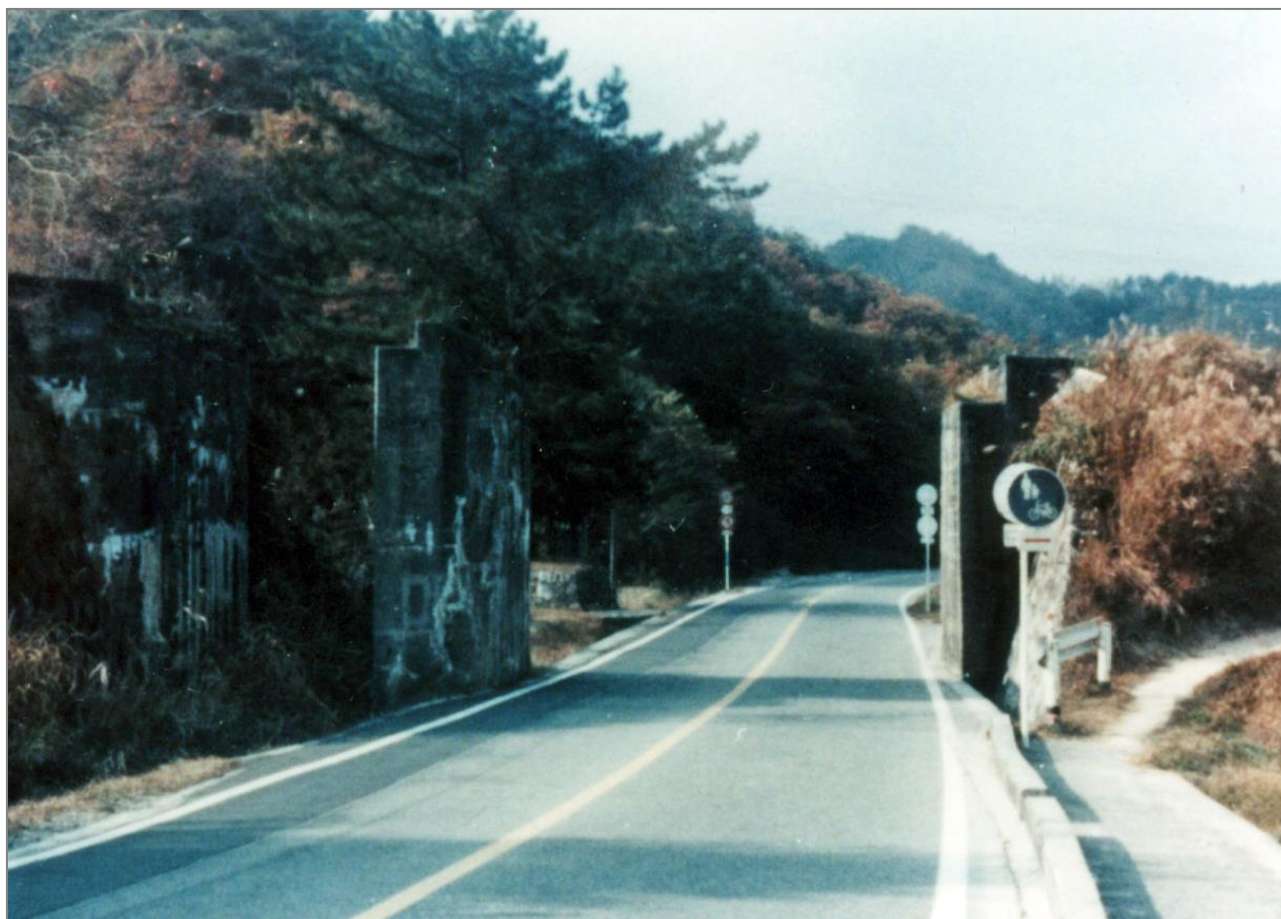
幻の橋脚跡(足助方から西中金を望む)…旧・パブリックゴルフ場手前(現・ゴルフ倶楽部大樹豊田コース)
